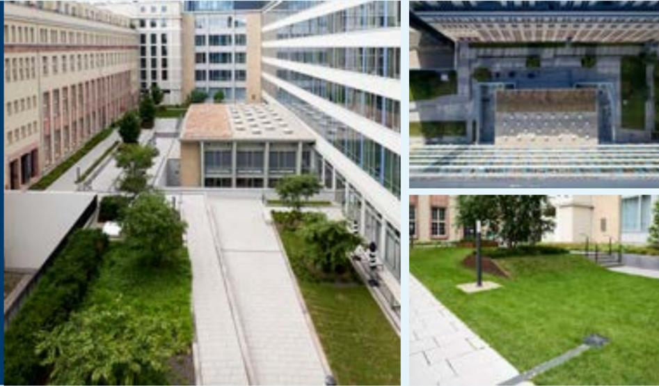
In Leipzig wurde der Hinterhof der Alten Hauptpost am Augustusplatz mit einem Retentionsgründach von knapp 700 m<sup>2</sup> ausgestattet. Dieser Retentionsraum bietet ein Speichervolumen von über 60.000 Litern Regenwasser und leistet damit einen wichtigen Beitrag zur Wiederherstellung des natürlichen Wasserhaushaltes sowie zur Verbesserung des Mikroklimas in Zeiten der Klimaerwärmung.
